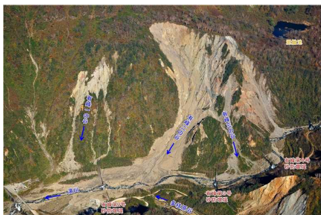
写真-1 有峰二の谷斜面崩壊地全景
