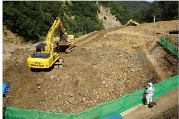
写真-3 無人化施工 操作状況
