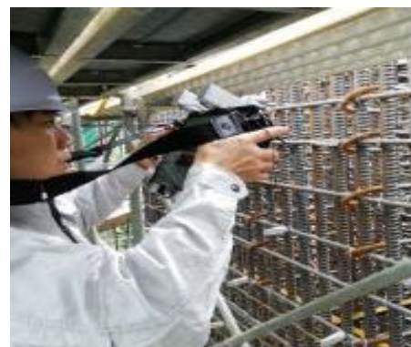
写真10 配筋検査状況
