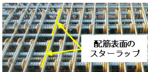
写真7 配筋表面のスターラップ
