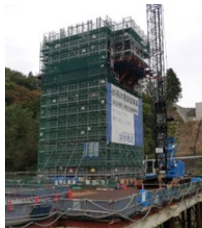
写真3 妙高大橋現場状況
