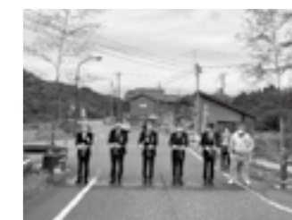
(一)湯之河内梶屋敷停車場線で 実施した竣工式の様子 新潟県 糸魚川地域振興局 地域整備部 道路課 佐藤 菜央 さん▶P.30
