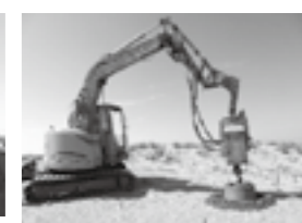
専用バケットを用いた砂浜緑化工法(はまドリル) ▶P.29
