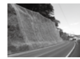
高エネルギー吸収型ポケット式落石防護網(強靭防護網(きょうじんぼうごあみ)) ▶P.28
