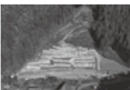
恒久工事完了写真▶P.11
