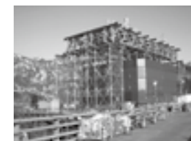
国道49号 揚川橋新設工事 (新潟県) ▶P.23
