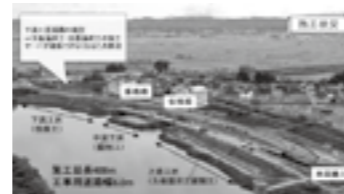
施工状況写真▶P.5
