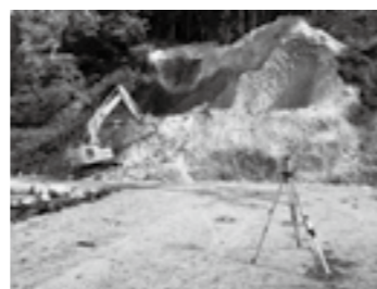
ICTプレーカー掘削状況 ▶P.7
