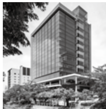
富山県防災危機管理センターの外観 ▶P.3
