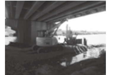
既設鋼矢板引抜き状況▶P.87
