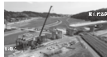
アプローチ部の架設(TC架設工法) ▶P.5
