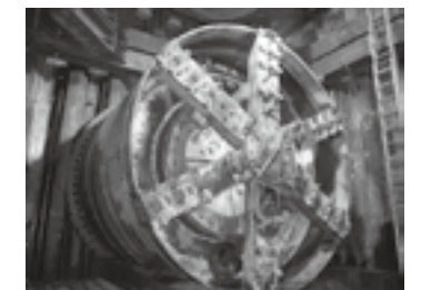
新潟市白根水道町ポンプ場建設工事 ▶P.17
