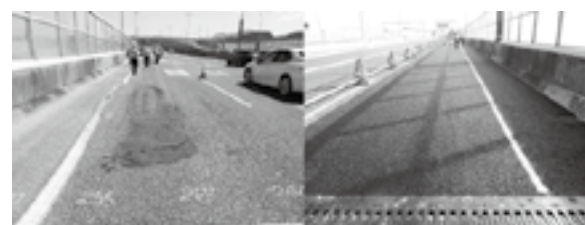
施工前後の状況(左：施工前、右：施工直後)▶P.11
