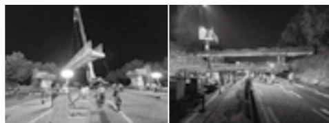
状況写真：人母橋(左)・道林釜屋第1橋(右) ▶P.25
