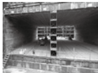
内部掘削完了時写真▶P.27
