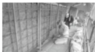
乾式吹き付けによる断面修復状況
