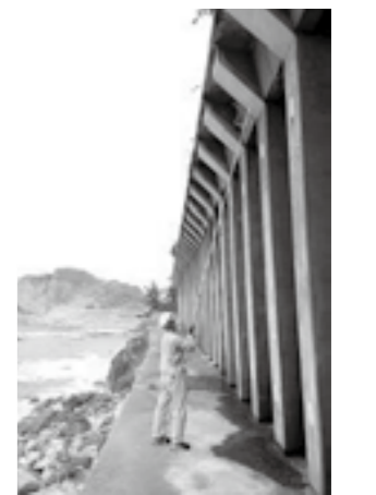
構造物の打音調査用具▶P.23
