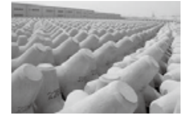
新潟港（西港地区）における消波ブロック▶P.19
