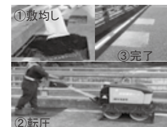
①敷均し ②転圧 ③完了 エコ型常温路面補修材（本復旧対応） ▶P.26
