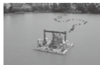
福島県 浚渫状況▶P.11
