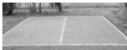
施工場所 (3か月後)
