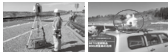
TLSによる現況測量 MMS測量機本体 ▶P.5
