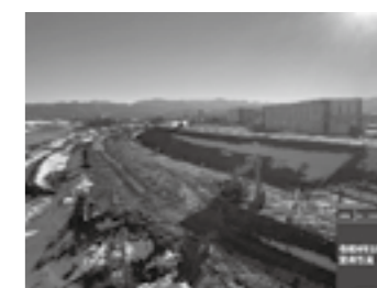
工事着手より2ヶ月経過後 日本海建興（株） 土木舗装部 吉田 周平 さん ▶P.100
