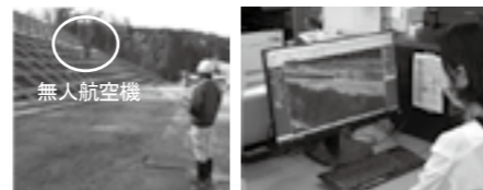
無人航空機による測量と3次元データによる出来形管理▶P.7
