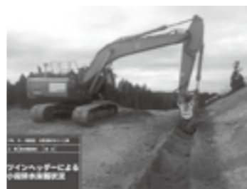
小段排水の掘削状況▶P.17
