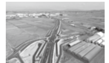
新潟中央環状線舗装工事 完成 (株)加賀田組 舗道部 横坂 龍 さん▶P.26
