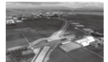
新潟中央環状線舗装工事 着手前
