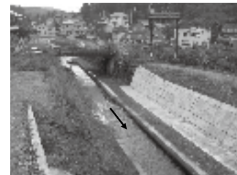
鉄道橋付近 改修後の低水路設置 状況（鉄道橋下流より望む）▶P.7
