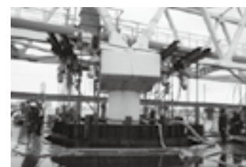
仮締切鋼板圧入状況▶P.15
