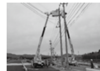
配電工事部▶P.17
