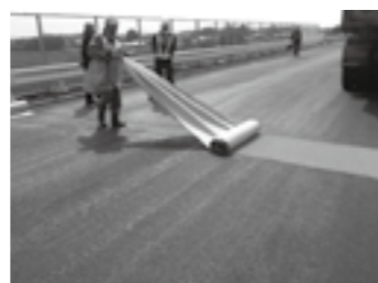
G・Asシート敷設状況▶P.11
