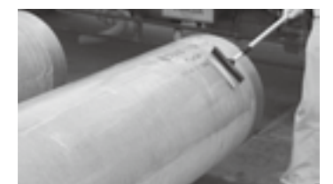
コンクリート管マニキュア剤 塗布状況 ▶P.46
