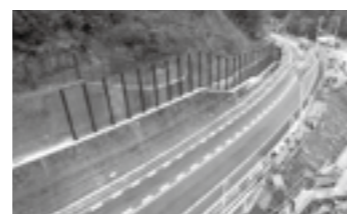
スロープガードフェンス設置 完成写真 ▶P.37
