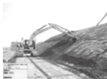
ICT建機による法面切土状況 ▶P.21
