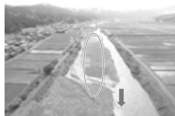
中州掘削後(能生川) ▶P.3
