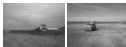
押土・敷均し状況 締りめ状況 ▶P.33
