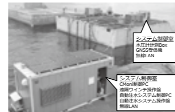
無人化据付状況▶P.9
