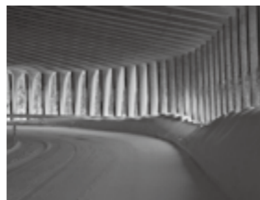
■コンクリートの芸術 (第23回建設写真コンテスト入賞作品)
