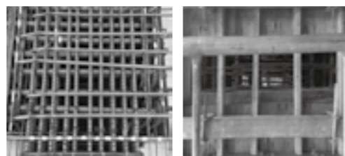
打設のぞき窓 柱部窓外側から ▶P.15
