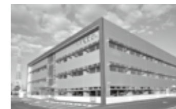
丹南電気ビル新築工事のうち 建築工事 ▶P.19
