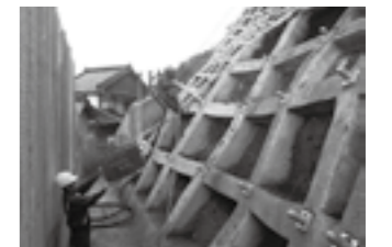
週休2日制モデル工事 仮囲い(左側)及び施工状況 ▶P.21
