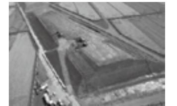
国土交通大臣賞 本郷サーチャージ盛土(その2)工事 ▶P.19
