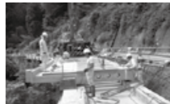
ロードプラス搬入状況 ▶P.5
