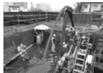
水平・斜め施工状況▶P.10
