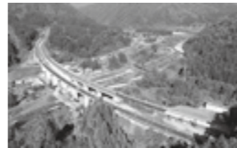
磐越道 付加車線工事 完成写真(終点部)▶P.7
