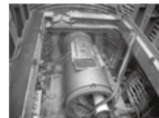
県水送水管工事 推進工事状況 ▶P.17
