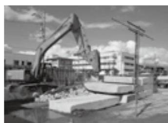
敷地境界部分に設置した 散水スタンド▶P.7
