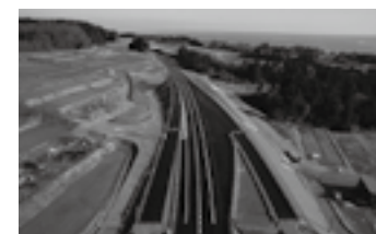
H26.能越道大泊(県境部)舗装工 その1、その2工事 ▶P.65
