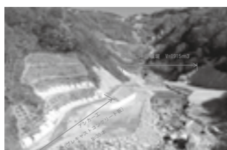
H27・28柳谷中流砂防 堰堤群工事 ▶P.9
