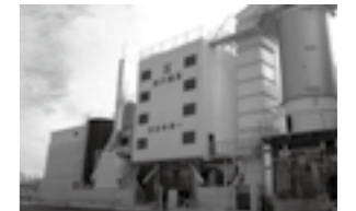
アスファルトプラント ▶P.21
