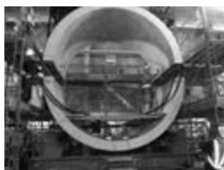
超大口径推進管上下部材接合状況
