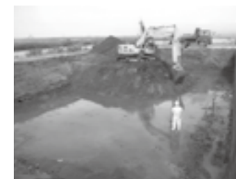
梯川の工事▶P.17
