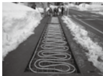
放熱管敷設状況▶P.7
