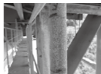
検査路の外観▶P.9
