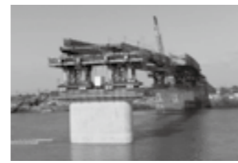
送り出し架設作業状況 ▶ P. 7
