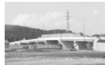
古栄跨線橋 ▶ P. 5
