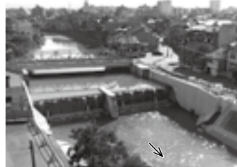
小橋用水堰 (鋼製起伏ゲート2門： 純径間 15.9m× 扉高 3.9m) ▶ P. 7
