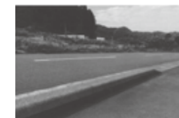
目地バリシート施工後▶ P.21
