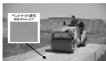
NB工法の施工状況▶ P.11
