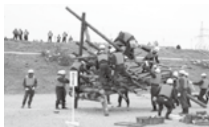
堤防への水衝りを柔らげる川倉工 ▶ P. 3
