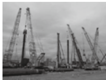
輻輳する工事状況▶P. 3
