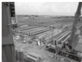
桁製作ヤード▶P.13
