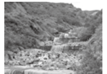
甚之助谷堰堤群の現状(平成24年)▶P.25
