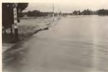
昭和 44 年 8 月 国道 8 号 - 冠水
