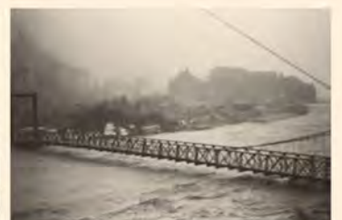
昭和 44 年 8 月音沢地区へ濁流始まる
