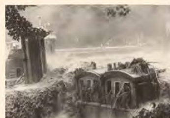
昭和 44 年 8 月 _ 愛本堰堤
