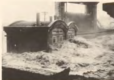
昭和 27 年 7 月愛本堰堤
