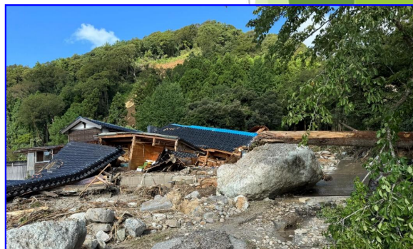
R6.9.20大雨による土石流被害：死者1名ほか (輪島市田野町南時国)
