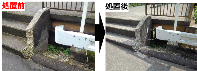
(ダム) 展望広場の階段にて転落防止措置を実施
