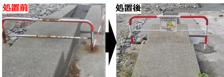
(海岸) 腐食により破断していた防護柵の補修
