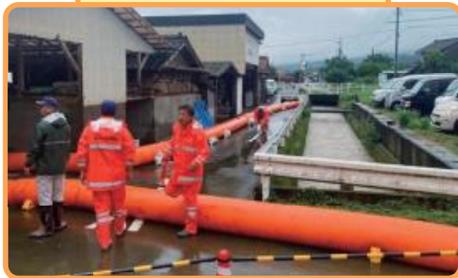
水防工法(大型水のう)
