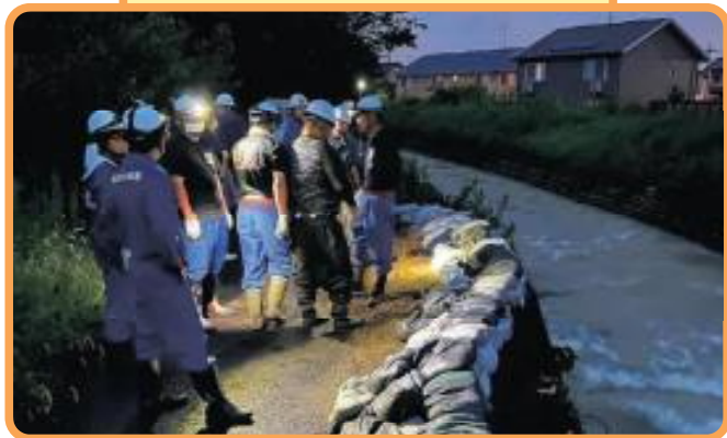
水防工法(土のう積み)
