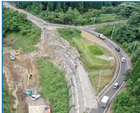
1/1 能登半島地震 国道359号（内山地内）道路崩落、6月11日交通解放
