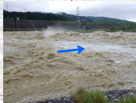
L13. 2k_愛本堰堤床止め付近 7月1日 10時24分
