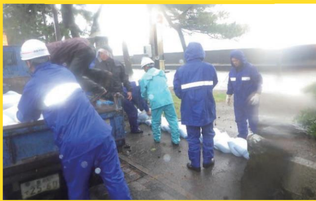
水防工法(土のう積み)
