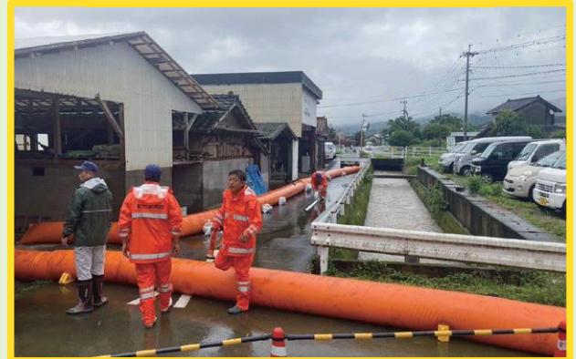
水防工法(大型水のう)
