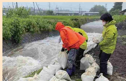
静岡県御殿場市消防団 積み土のう工を実施 (令和3年7月3日:久保川左岸)
