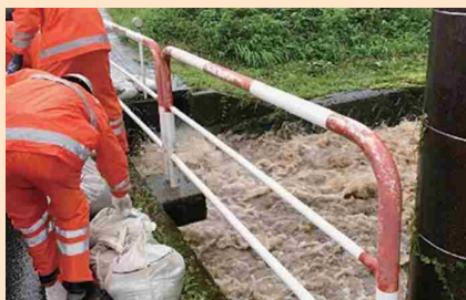
岐阜県下呂市消防団 積み土のう工を実施 (令和3年8月13日～18日:下呂市萩原地区)
