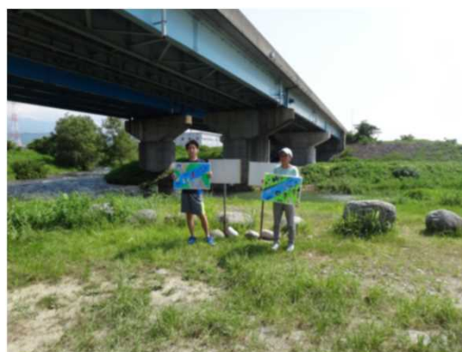
令和元年 設置写真
